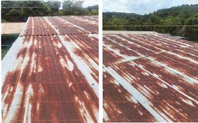
Foto 3: Cambio de techo de un aula.
