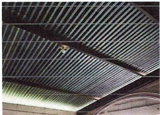
Foto 4: Reparación de instalación eléctrica.
