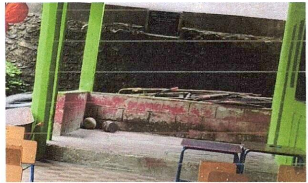
Foto 4: Colocación de piso antideslizante en el corredor de la cocina.
