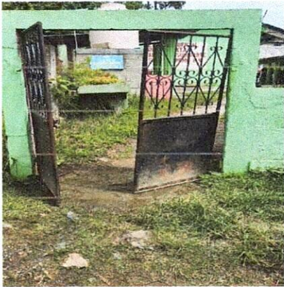
Foto 3: Construcción de una rampa de acceso al centro educativo.
